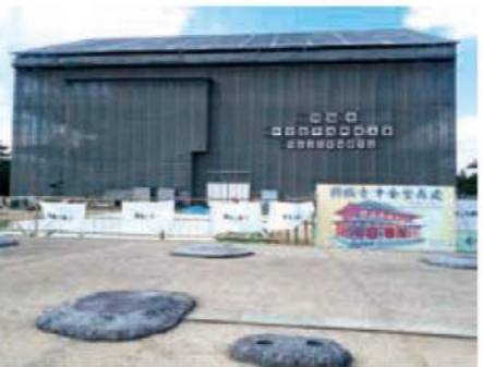
覆屋のなかの新しい中金堂。手前に穴がふたつあいた礎石がみえる。(2018.4.8撮影)
